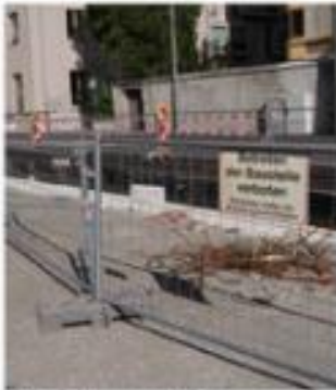
Hier bekommen Sie einen groben Überblick über aktuelle Baustellen in Innsbruck.
