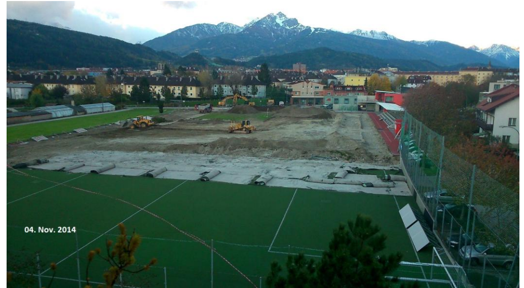
ein Teil des vermutlich illegal erbauten Kunstrasens muss der Vergrößerung weichen
