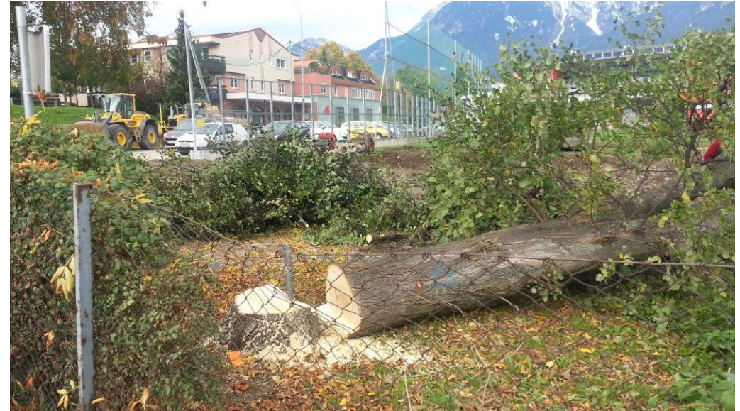
Baumfällen am Standort des Denkmalgeschützen“ Roßsprung“
