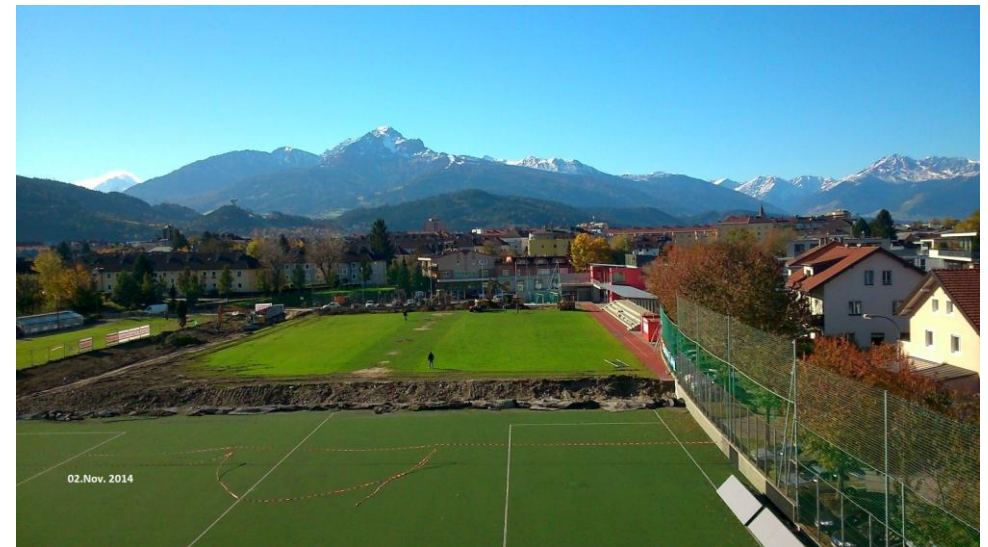
Abriss der Stützmauer, welche vor nicht mal 2 Jahren neu errichtet wurde!
